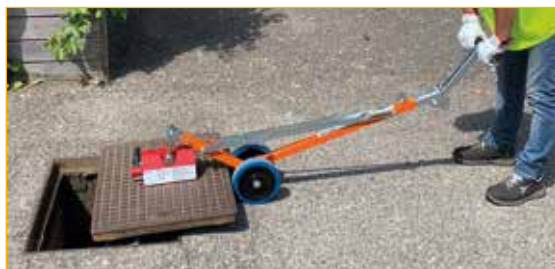
Utilizzo 4: sollevamento magnetico con magnete permanente (PM400 o PM500) opzionali per chiusini molto pesanti.
